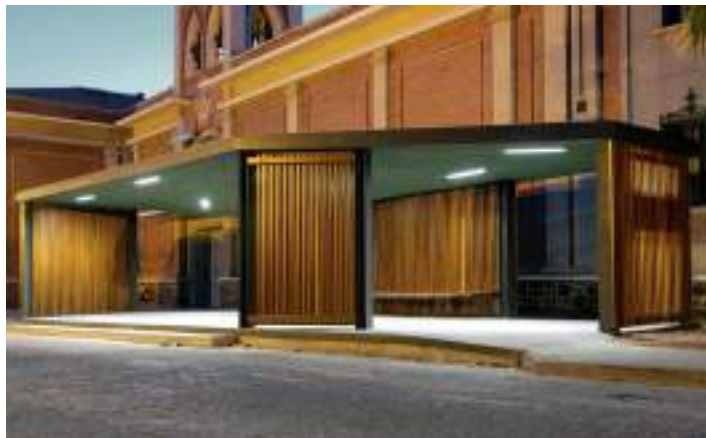
Figura 83. Marquesina de autobuses en Daroca. Fuente: Archdaily 2022.
