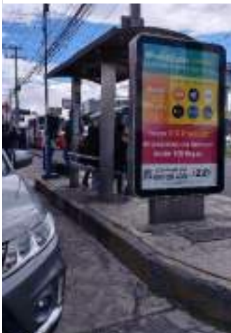
Figura 30. Mobiliario en parada 1.1E. Fuente: elaboración propia.
