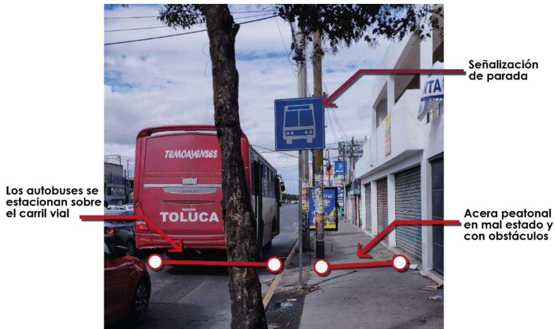
Figura 65. Infraestructura encontrada en paradas Tipo C. Fuente: elaboración propia.
